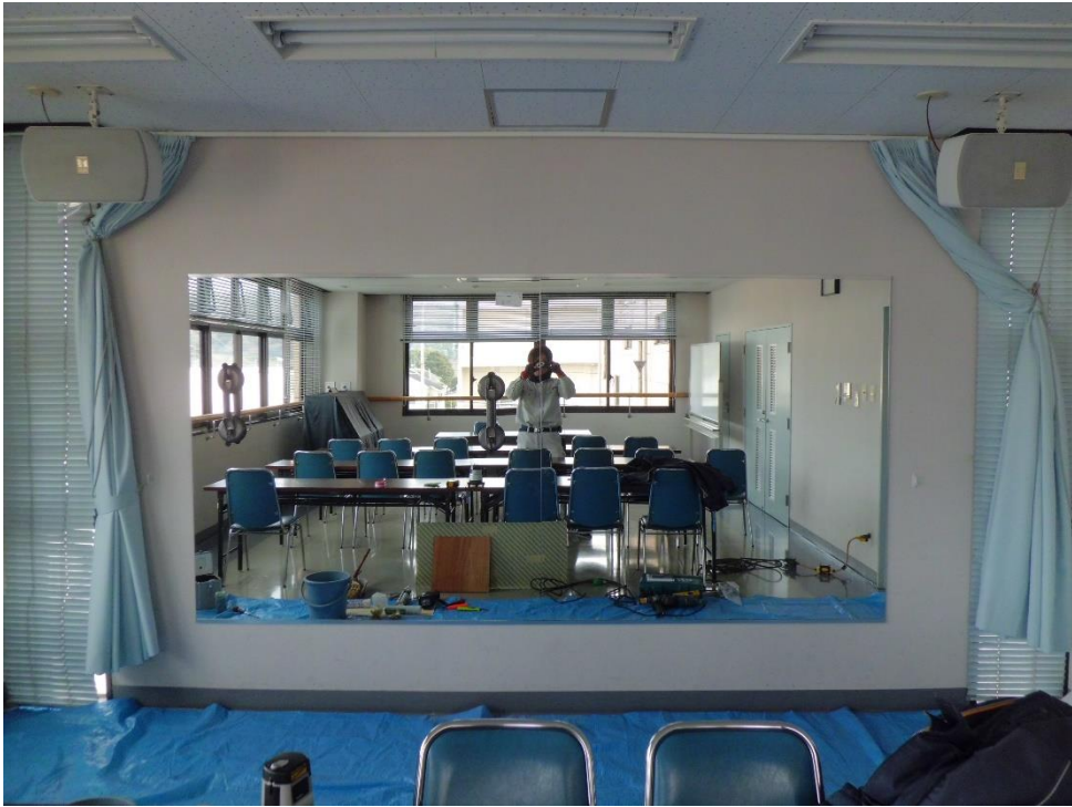
鏡取付・カーテン取付完成 施工後
